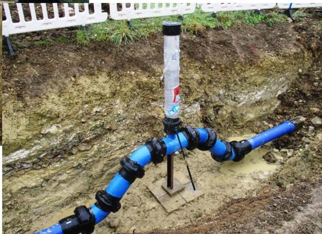
erdeingebautes BEV mit großflächiger Anböschung
